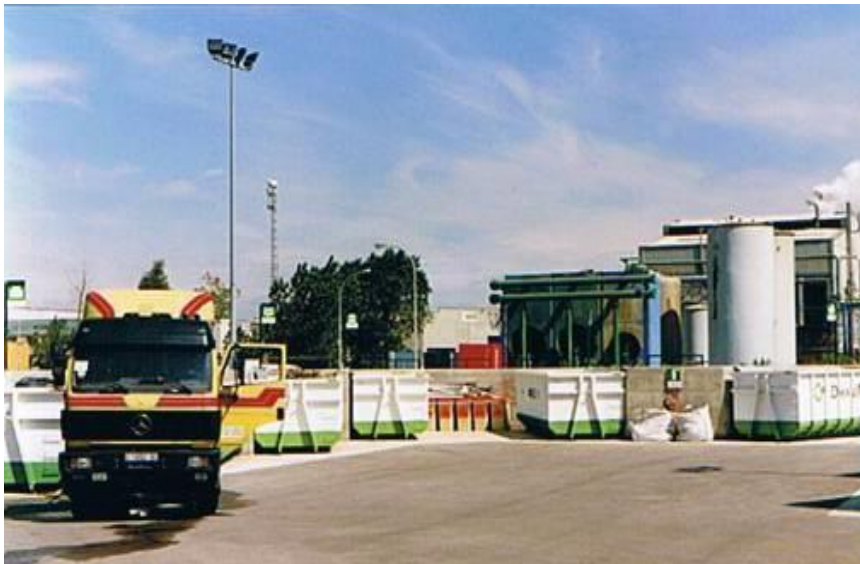
Montcada i Reixac Waste Recycling Centre
